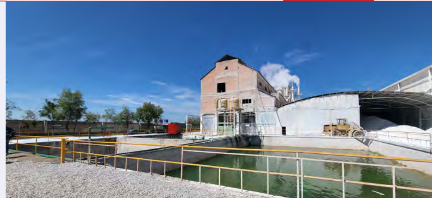
Piletas de almacenamiento de agua por captación pluvial de Planta Aguascalientes
