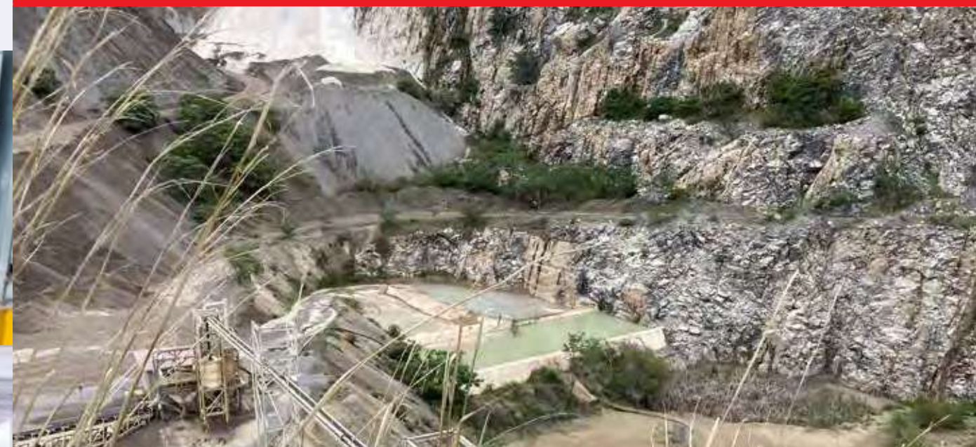
Piletas de almacenamiento de agua por captación pluvial de Planta Tecolotlán
